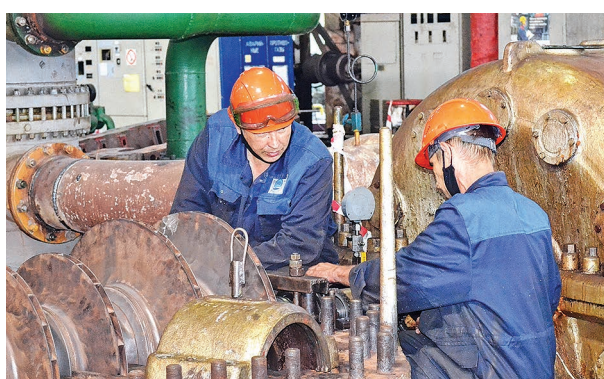
Сборку компрессора в машинном зале цеха кальцинированной соды №1 ведут работники РСМУ
