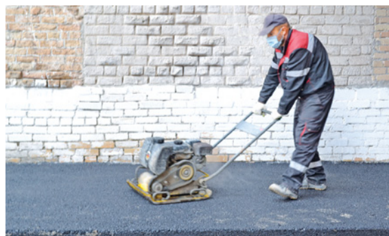
Помимо автодорог на территории завода отремонтировали и тротуары
