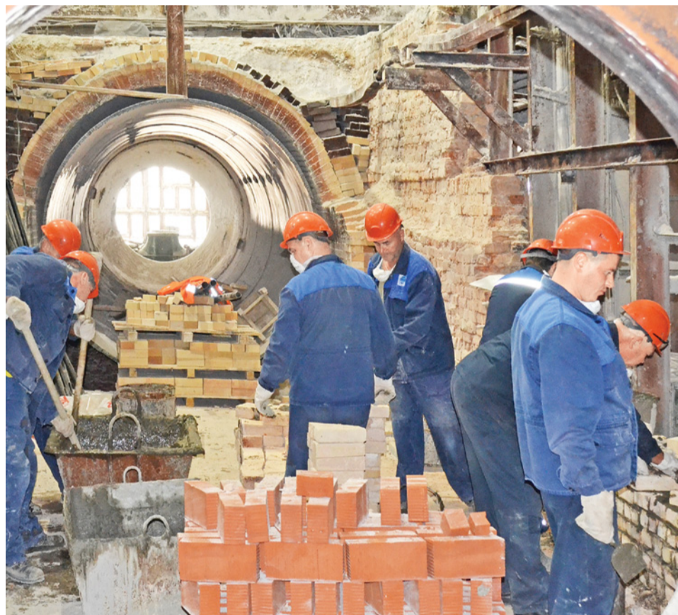
Огнеупорщики строительного участка РСМУ возводят кирпичную кладку содовой печи
