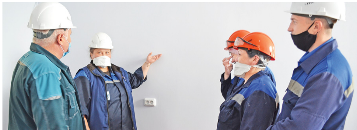
Ремонт в АБК электротехнического участка. Качество работ оценивает начальник участка Игорь Уральский (слева)
