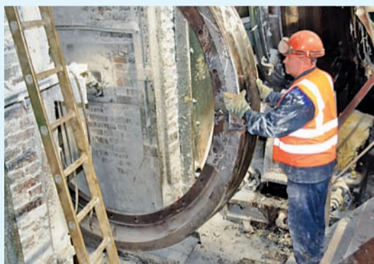
Демонтаж оборудования содовой печи №1
