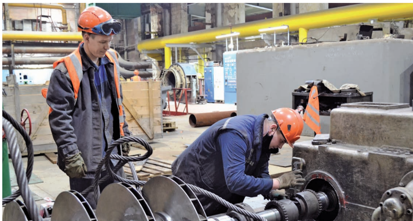
Установкой турбокомпрессора на раму и подгонкой, выставлением редуктора занимаются специалисты РСМУ
