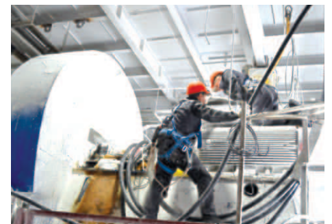
Специалисты подрядной организации меняют моторный кабель основного приточного вентилятора для поддержания кипящего слоя в сушилке вентилятора поз. 13.03 в отделении производства кальцинированной соды марки А
