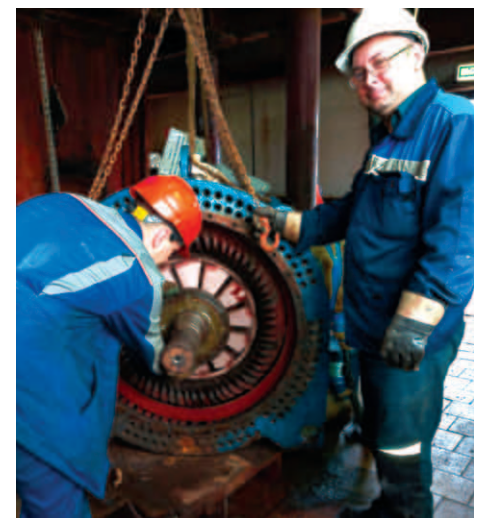
Ремонт электродвигателя позиции 8П-2 узла приготовления пульпы цеха №10 проводят электромонтёры по ремонту и обслуживанию электрооборудования Антон Брызгалов и Леонид Кычанов
