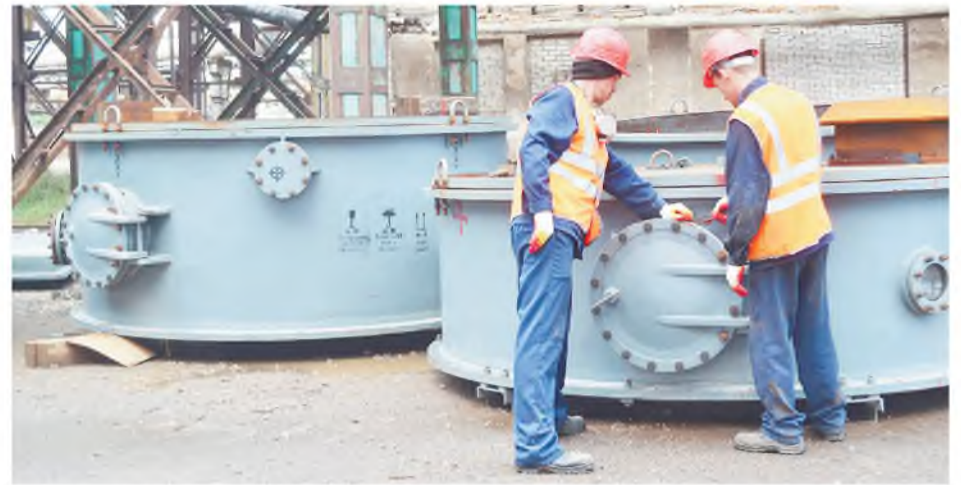
Подготовка колонного оборудования к монтажу
